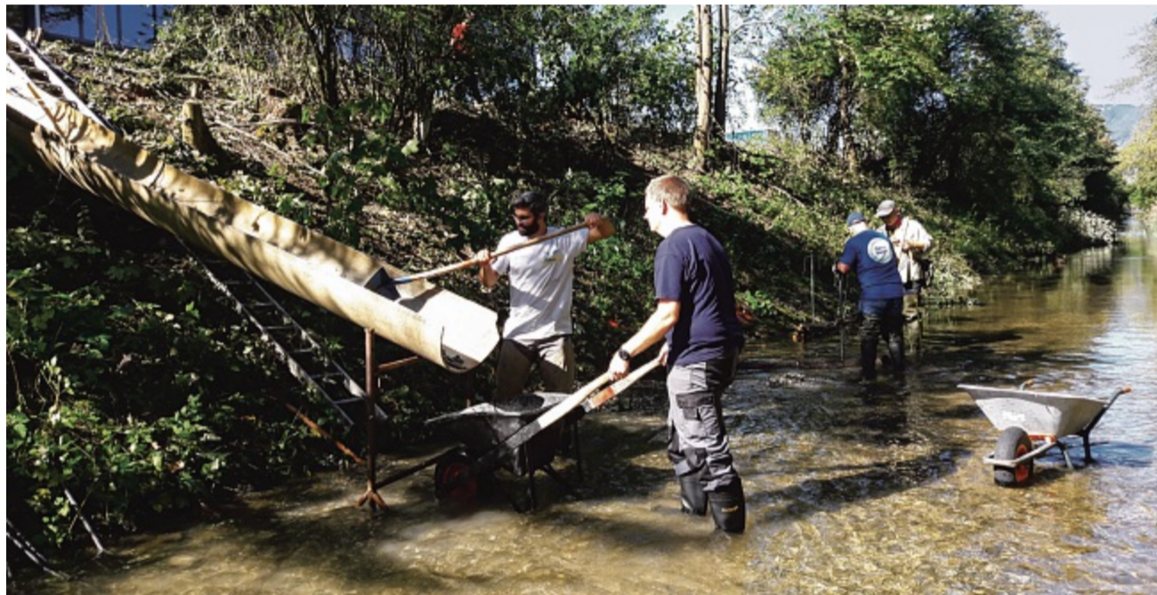
Kies als Laichsubstrat: Rund drei Kubikmeter wurden im Bachbett der Dünnern verteilt.
